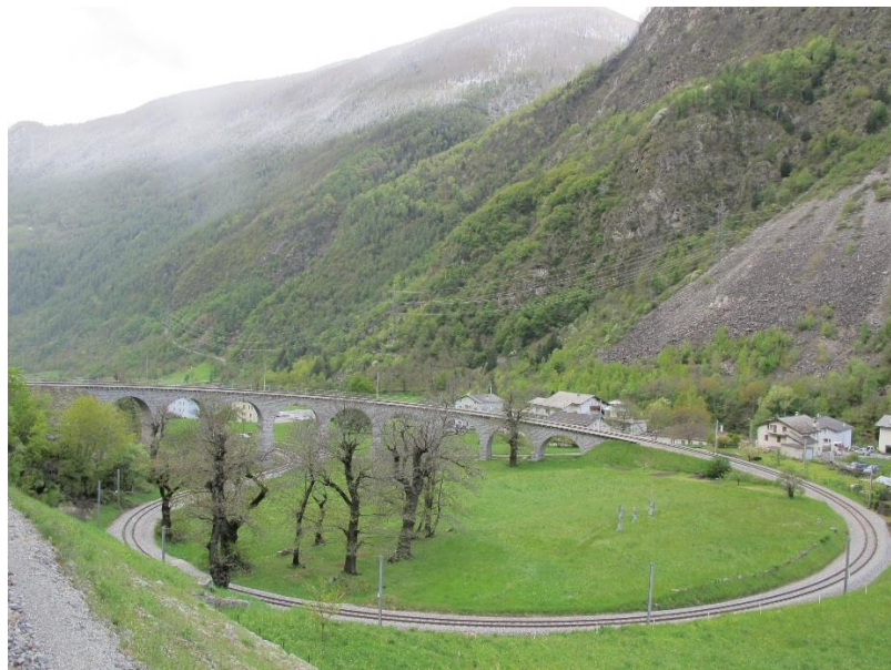
Viadukten i Brusio
